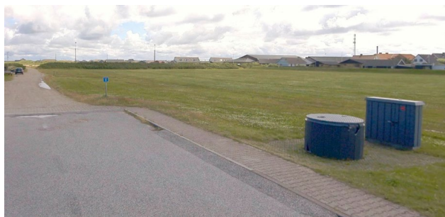
Figur 2 - Tekniske installationer ved skel langs Enghavevej
