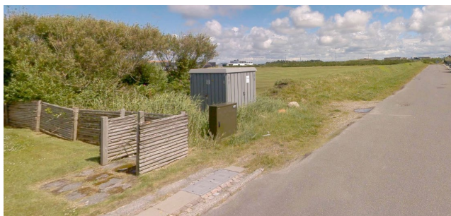
Figur 1 - Tekniske installationer ved skel langs Jagtvejen
