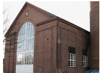
Den bevaringsværdige kedelbygningens østvendte gavl.
