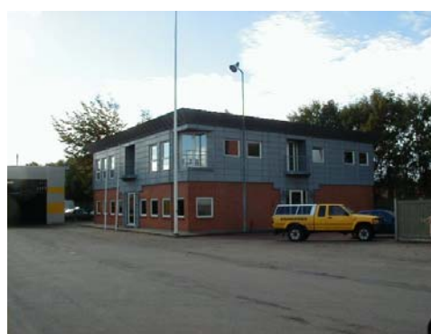
Figur 5-7 Hovedbygning 3 med kontorer.
