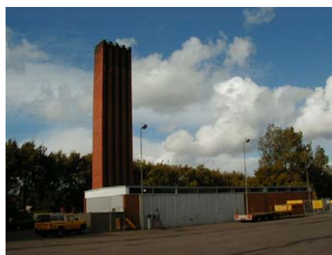
Figur 5-5 Varmecentral m. skorsten.
