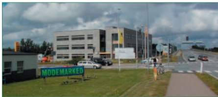
Nyopført kontorbygning nord-østligst i lokalplanområdet med Ringvejen til højre i billedet, set fra øst.
