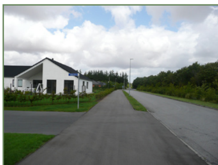
Vej a-a's udmunding i Storåvej:
