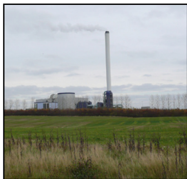
Vue mod nordvest - mod Måbjergværket.
