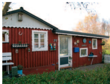
III. 3. Bygning i havekolonien Ellebæk.
