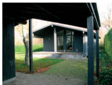
III. 2. Bygning i havekolonien Ellebæk.
