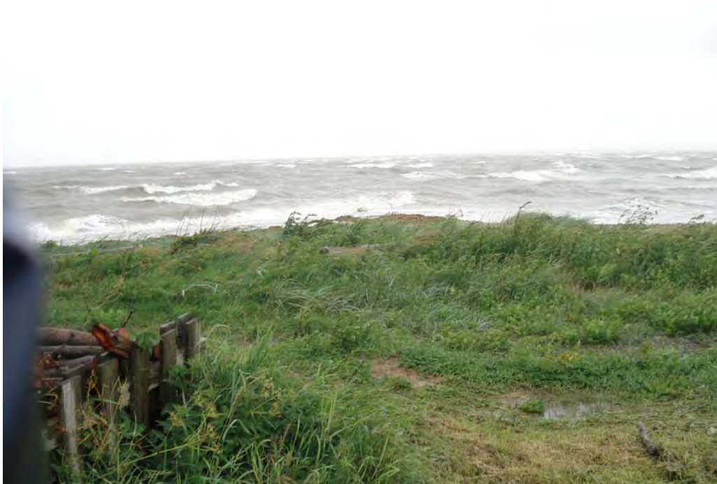
Figur 3: Stranden ved P-anlægget ved Handbjerg Strand
