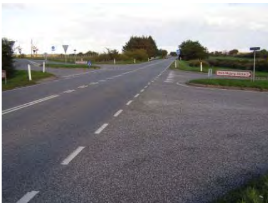
Figur 21: Vejadgang fra Struervej til Handbjerg over jernbaneoverskæring (Foto: Rambøll, oktober 2006)
